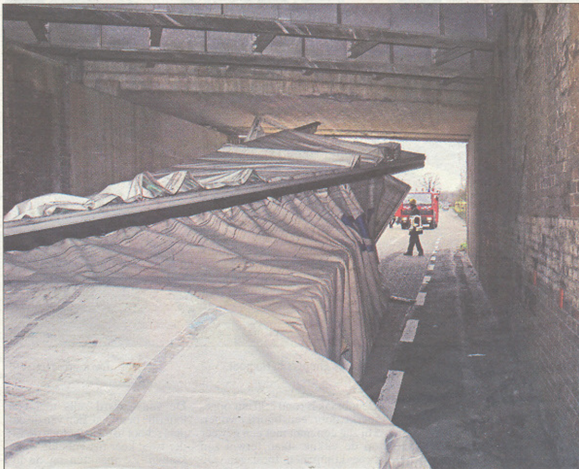
De zoveelste vrachtwagen die zich in de vernieling rijdt onder de te lage brug op het industrieterrein in Genk-Zuid.
